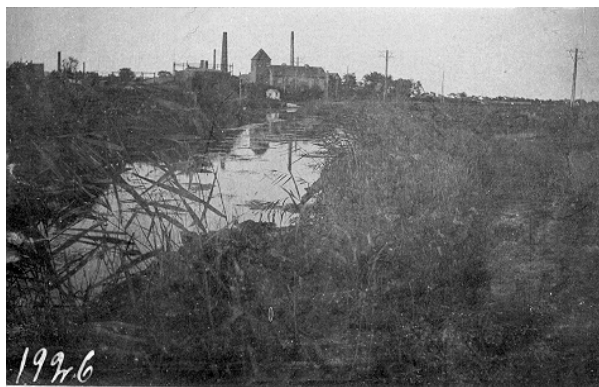
Grenåen med elværket (indviet 1926) i baggrunden
