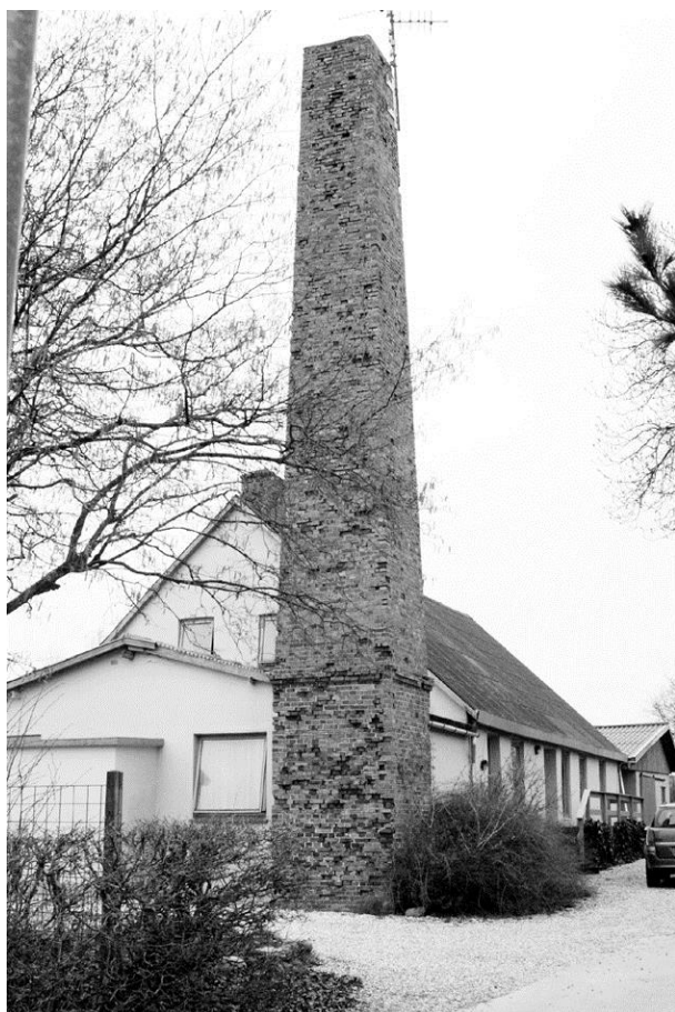
Det gamle Andelsmejeri Aalsrodevej 67 Foto 2006
