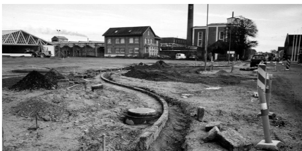
Østerbrogade marts 2004. Anlægget af den kommende rundkørsel i krydset N.P. Josias-sensvej/Østerbrogade. I baggrunden byggeri af supermarkedet LiDL, førhen det nu sanerede Svineslagteri, samt Grenaa Dampvæveris bygninger
