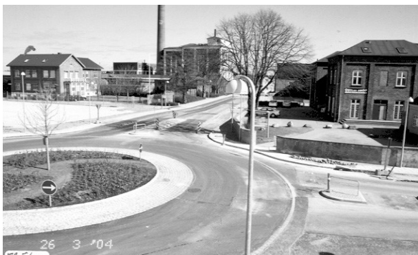
Den nye rundkørsel med et kig ned ad Havnevej marts 2004
