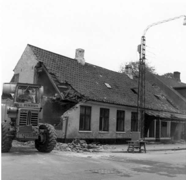
Østergade 13 saneres 1970. Ejendommen med "Nyssers Blomster" nedrives for at give plads til Rosengades nye udmunding til rundkørsel og Østergade
