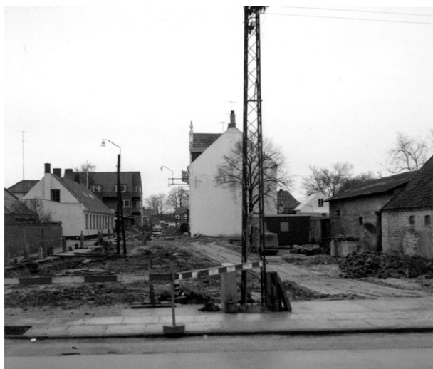
Rosengades nye udmunding til rundkørsel og Østergade 1971
