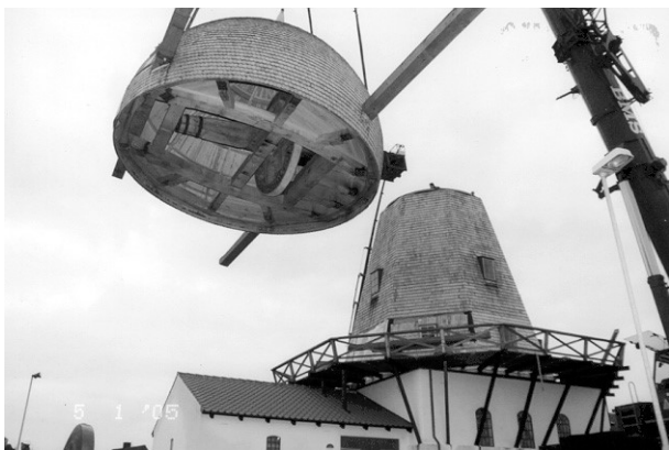
Møllehatten løftes på plads af en kraftig BMS kran
